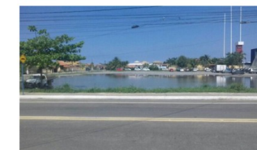
"Piscinão de Itaipuaçu? Área de estacionamento alaga após dias de chuva". Fonte: Itaipuaçu Online.
